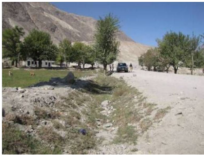
b)2011年拍摄 图3 K518+675.5~763.5处生态排水沟施工前后对比
