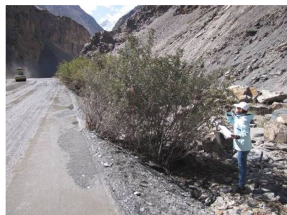
b)公路即将竣工
