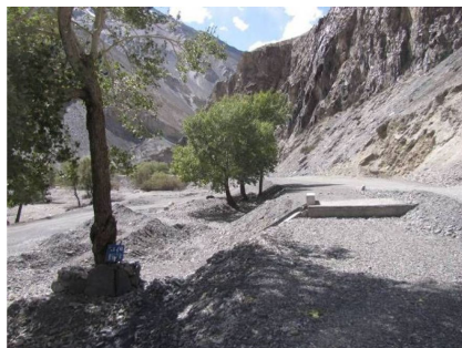
图5 收缩路堤边坡以保护路侧大树
