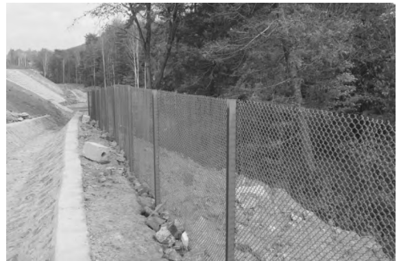
图 9 鹤大高速公路靖宇保护区段设置的哺乳动物隔离栅(网孔直径为 2 cm×2 cm)
